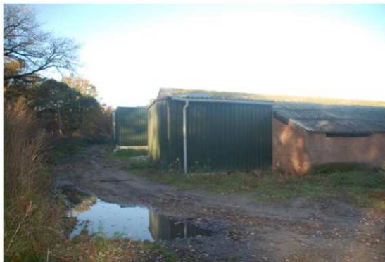
stallen achterkant met luchtwassers
