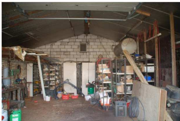
Te behouden werkplaats voorkant stal 4
