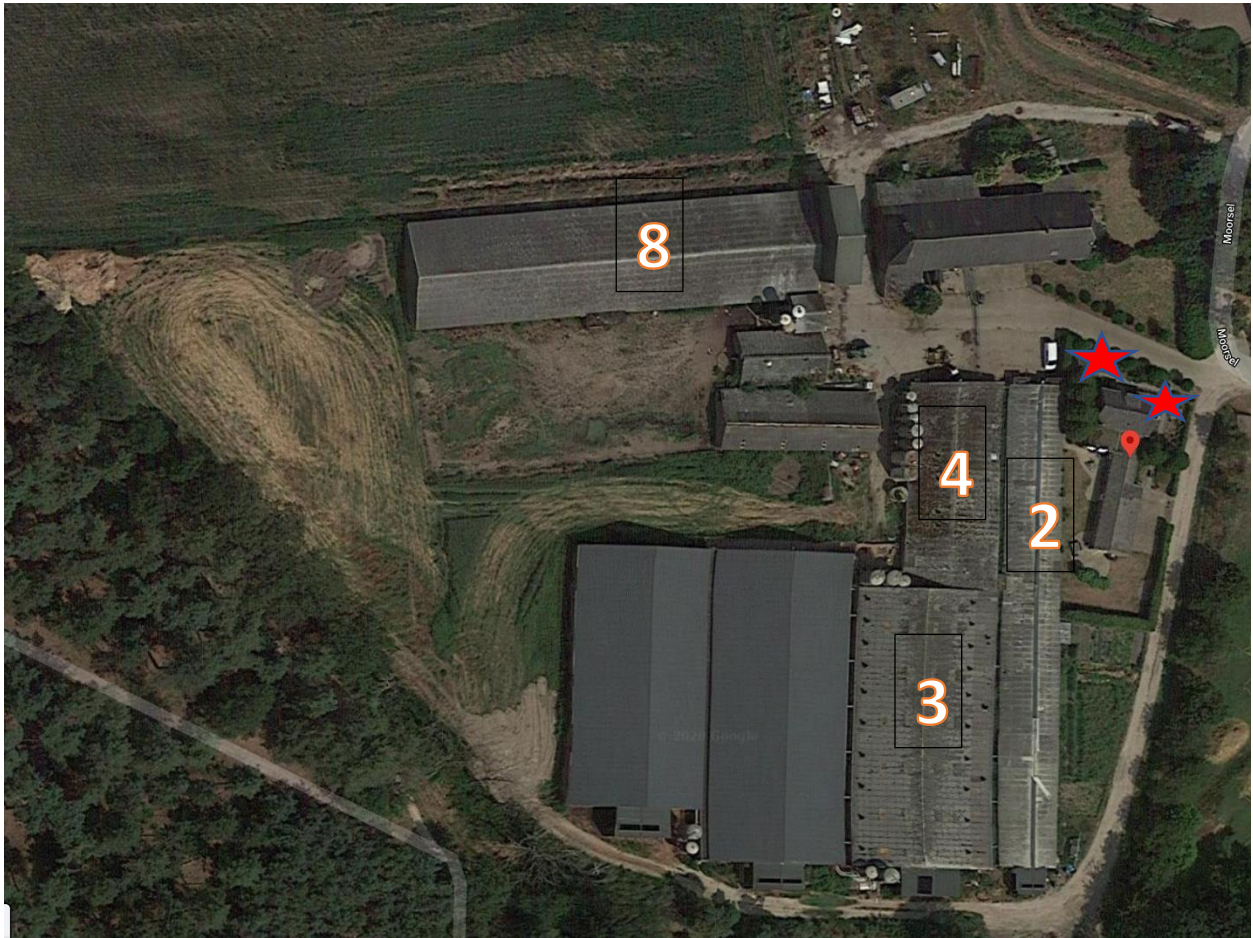
Bovenaanzicht :met in rood plaatsen huismus waargenomen en de stallen 2,3,4 en 8. Bron: Google maps.
