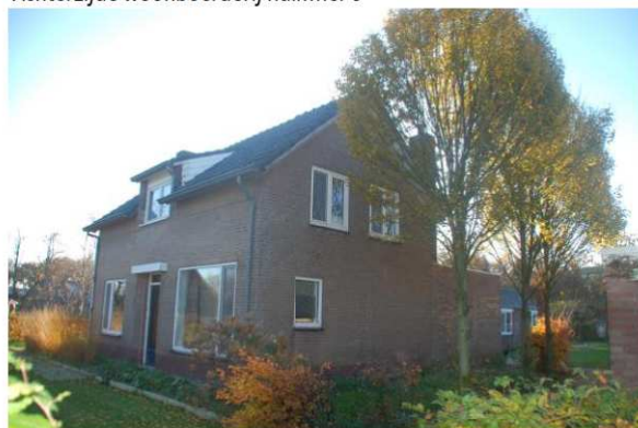
Achterzijde woonhuis nummer 11
