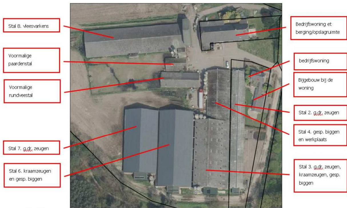
Afbeelding 3: overzicht aanwezige bebouwing
