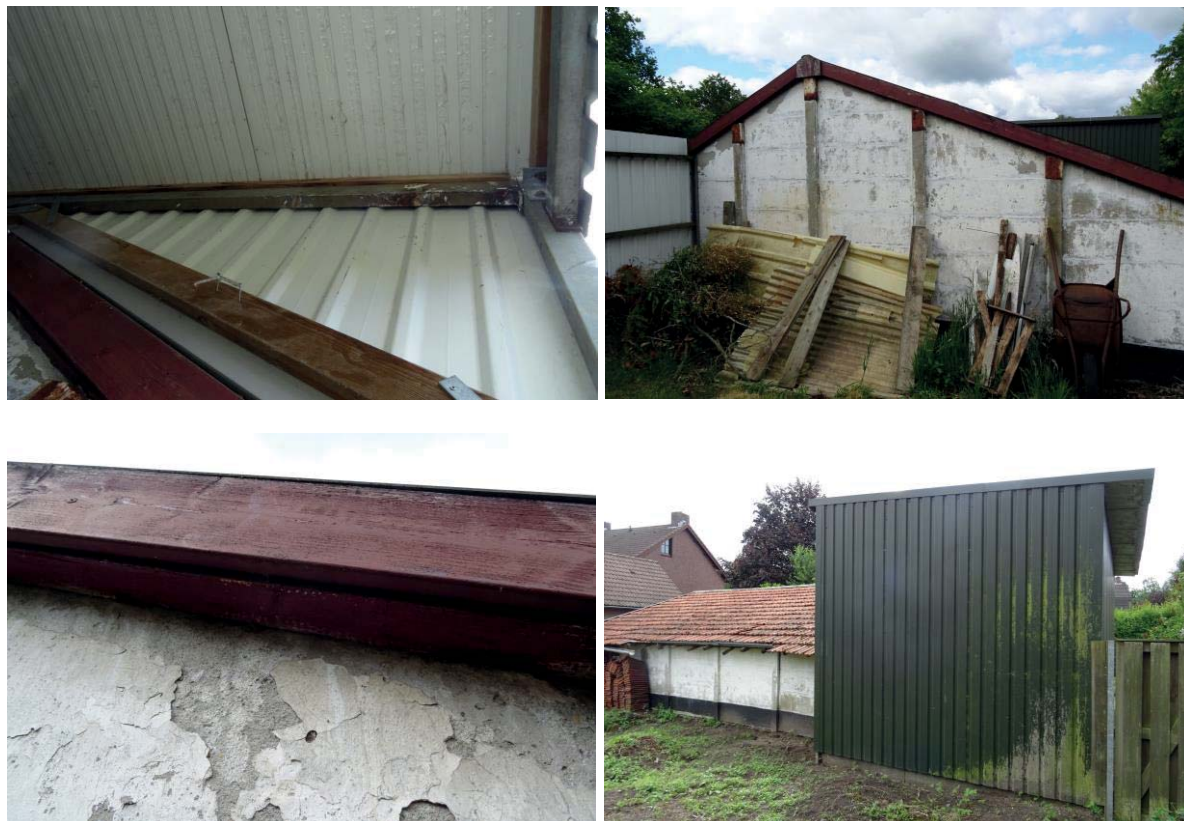
Afbeelding 7 t/m 10: Geen geschikte openingen/ invliegopeningen voor vleermuizen aangetroffen in de te slopen bebouwing. Bron: BNL advies, datum: 30-05-2022
