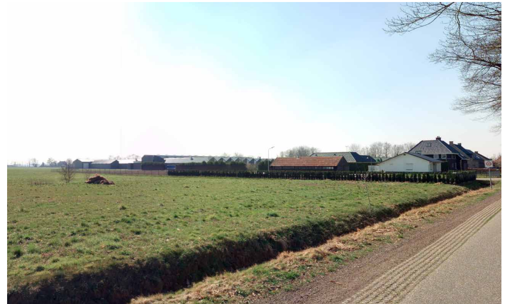
Figuur 4. Te saneren bebouwing van de champignonkwekerij (links), waarneembaar vanaf de Ploegstraat
