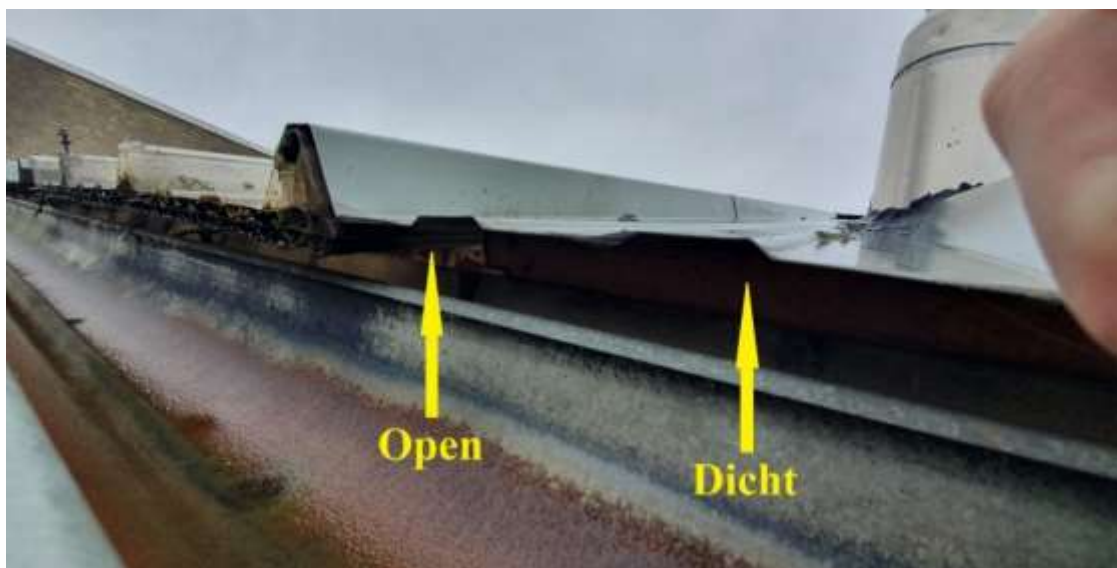
Figuur 4.4.1. Onder de lichtdoorlatende hardplastic platen is een opening aanwezig waardoor vleermuizen de spouw kunnen bereiken.
