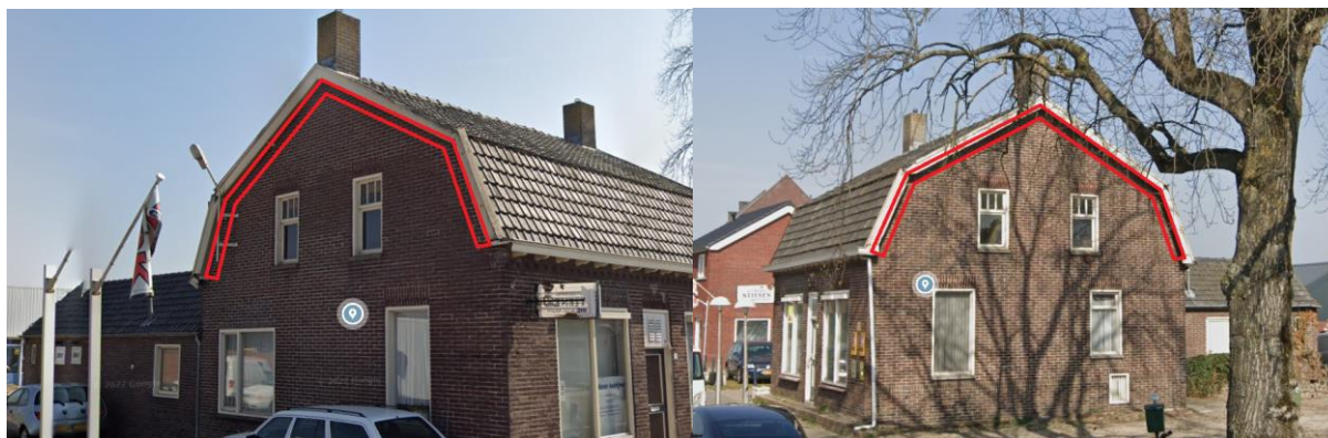
Figuur 5.3. Locaties waar alle openingen met spouwborstels of volièregaas worden gedicht (rood omlijnd).
