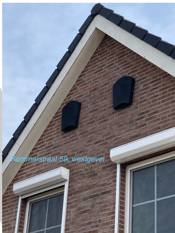
Kommerstraat 59 te Someren met 2 VK WS 02 vleermuiskasten aan de westgevel.
