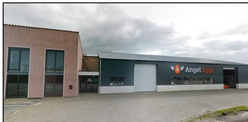
Figuur 2-2: Aanzicht plangebied vanuit noordwestelijke richting
