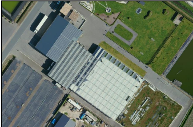
Figuur 2-3: De reeds gerealiseerde glastuinbouwkas 1
