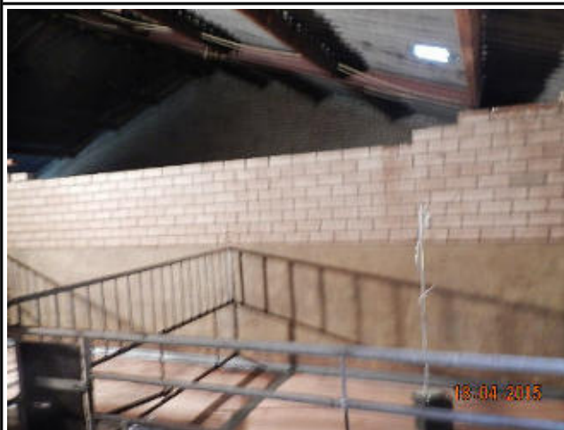
Foto 6: op afgedekte put pomp 2, boven topgevel verwijderd
