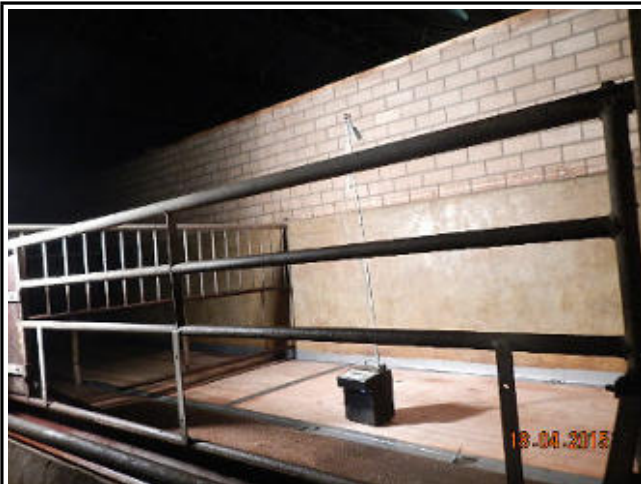
Foto 7: pomp 3, topgevel en plaatmateriaal in hokinrichting verwijderd
