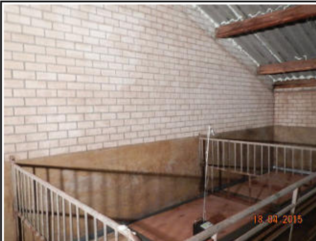
Foto 10: pomp 6 rechts achter in stal, plaatmateriaal in hokinrichting verwijderd
