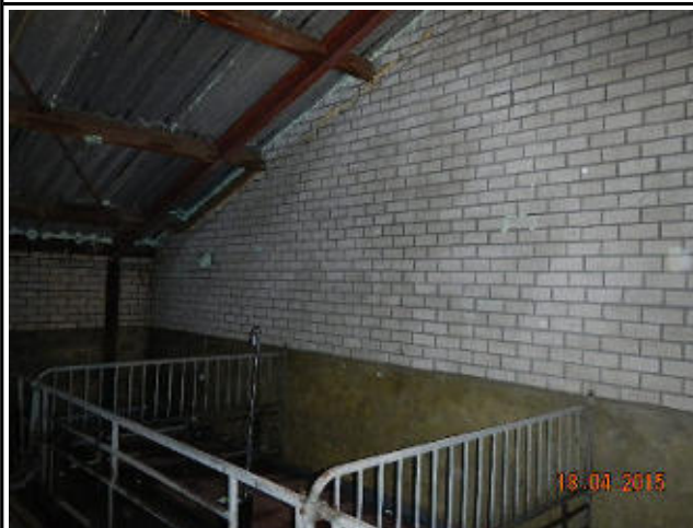
Foto 5: rechtsvoor in stal opstelling pomp 1, plaatmateriaal in hokinrichting verwijderd
