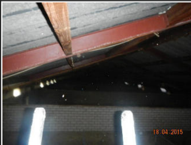
Foto 11: alle topgevels verwijderd
