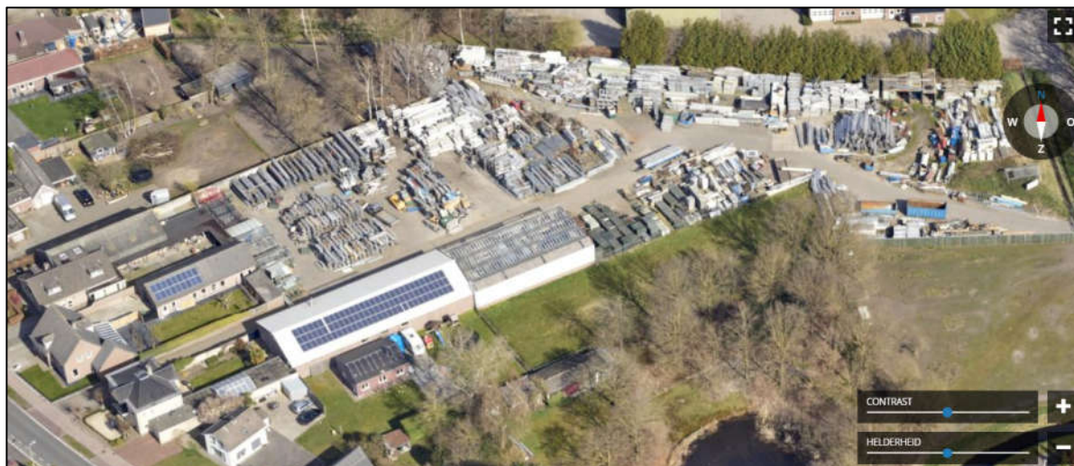
Figuur 5: Luchtfoto van de locatie aan Sluisstraat 63b-c in de huidige situatie
