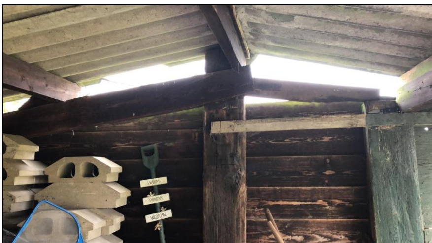
Figuur 20: Binnenkant bijgebouw
