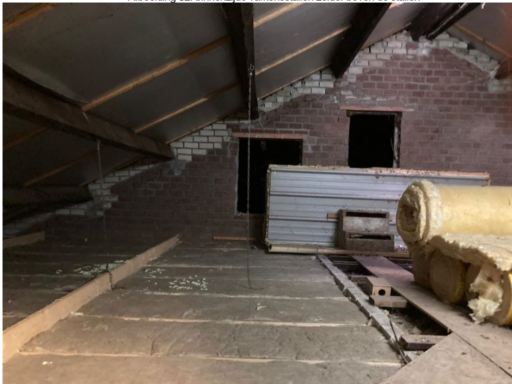
• Afbeelding 32: binnenzijde varkensstallen zolder boven de stallen
