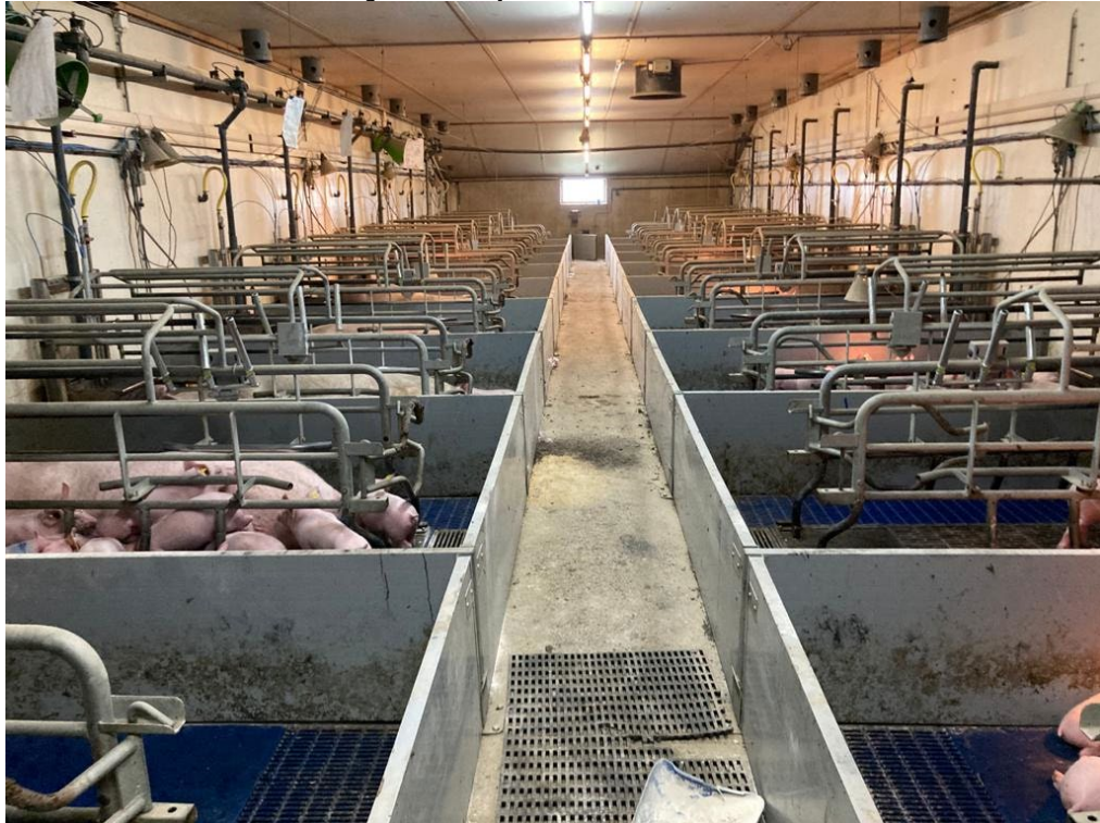
• Afbeelding 33: binnenzijde varkensstallen
