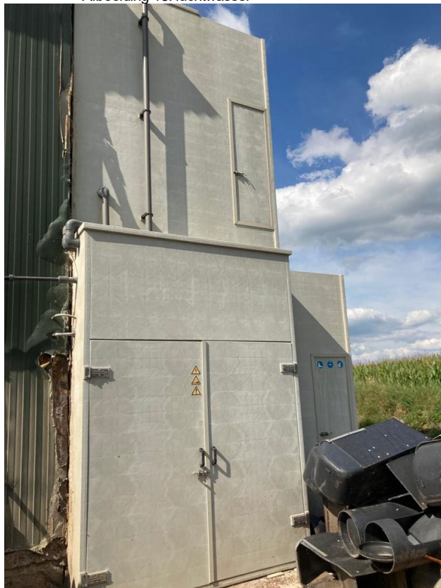
• Afbeelding 18: luchtwasser
