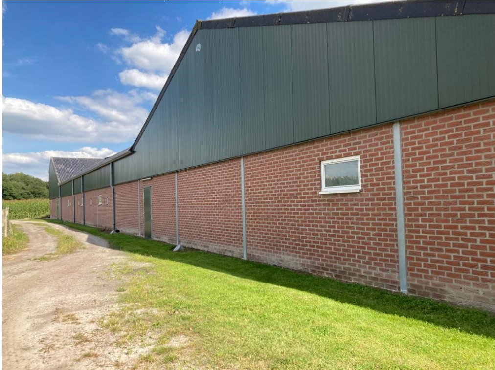
• Afbeelding 15: buitenzijde varkensstallen
