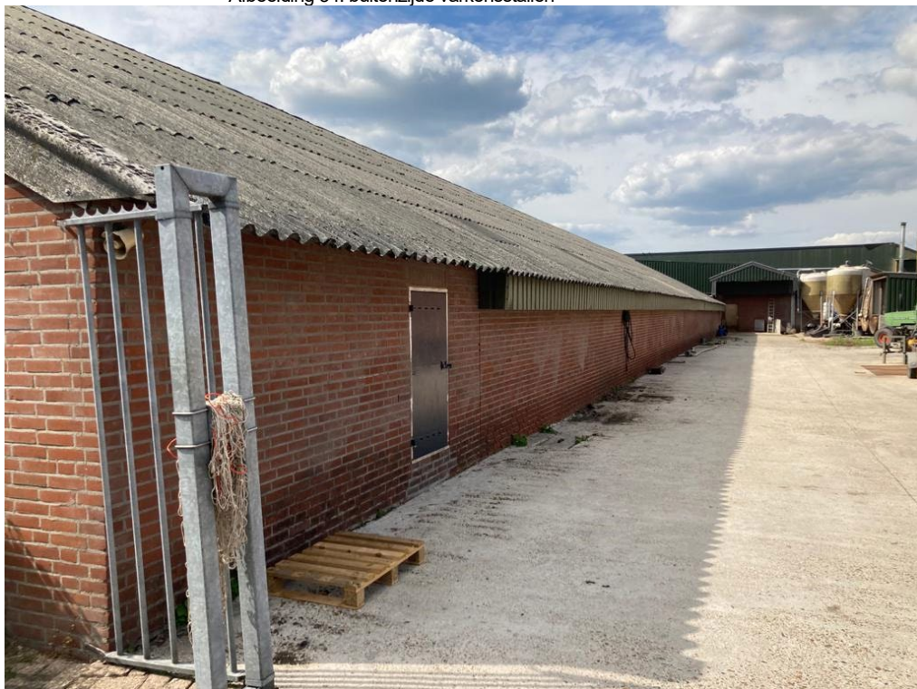
• Afbeelding 34: buitenzijde varkensstallen
