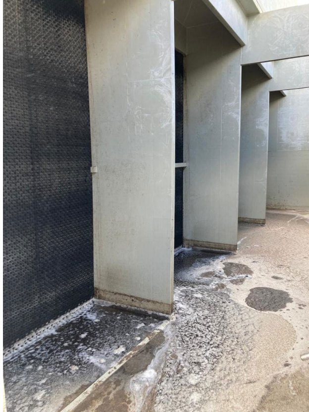
• Afbeelding 17: luchtwasser
