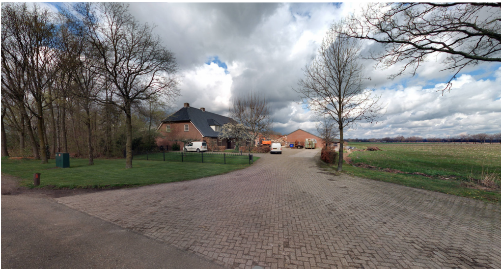
Oprit en aanzicht voortuin aan de zuidzijde van het erf - Cyclomedia
