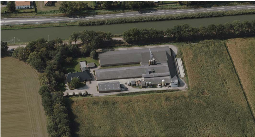
Obliëk luchtbeeld | zichthoek vanuit oosten - Cyclomedia
