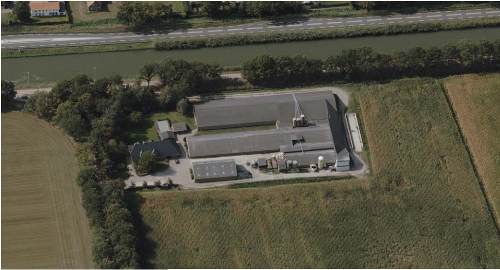
Obliëk luchtbeeld | zichthoek vanuit oosten - Cyclomedia
