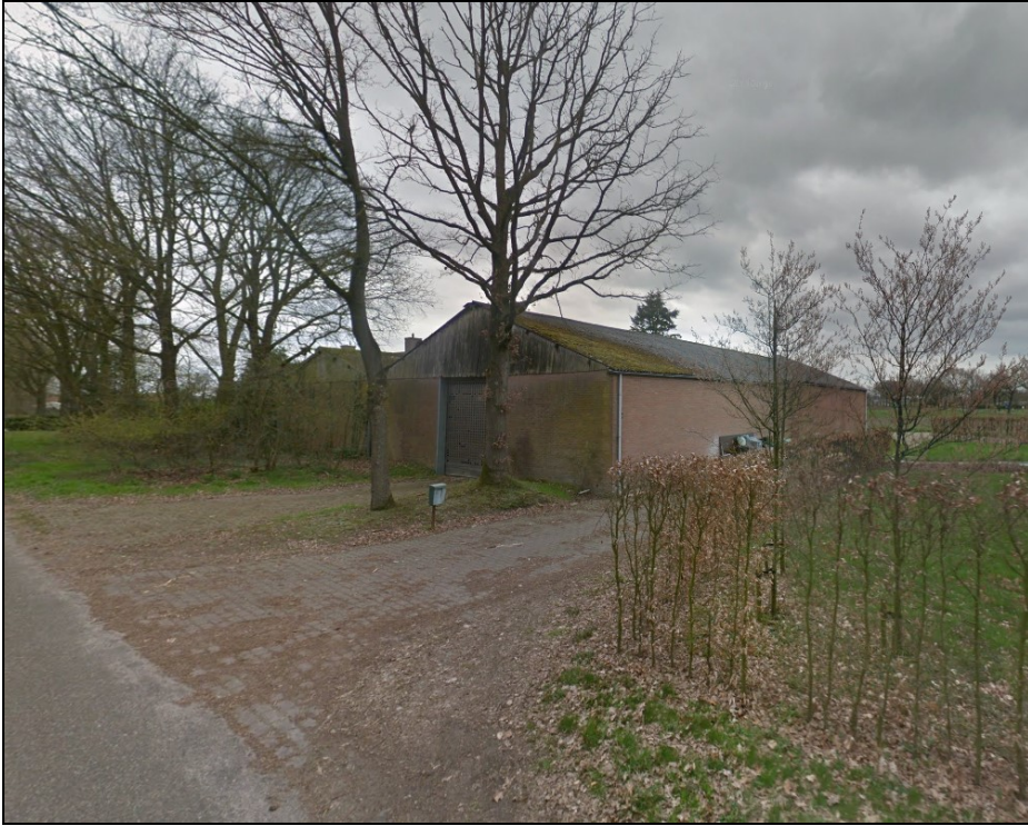
Figuur 6: Bedrijfsgebouwen op het achtererf
