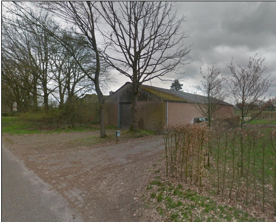
Figuur 6: Bedrijfsgebouwen op het achtererf
