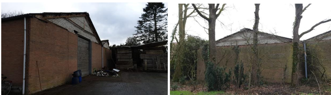
Afbeelding 3 en 4: Bestaande te slopen loods op de kavel aan de Bergdijk 4 Someren. Bron: R.J.L. Bijvelds 17-03-2021
