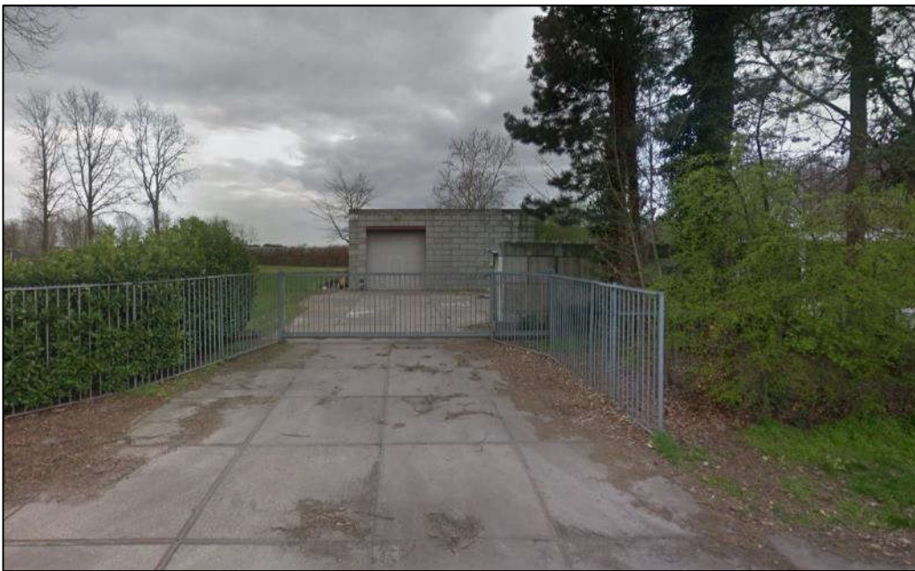
Figuur 5: Huidige situatie projectgebied Hoeksestraat 15a (boven) en bijgebouw Hoeksestraat 15 (onder)
