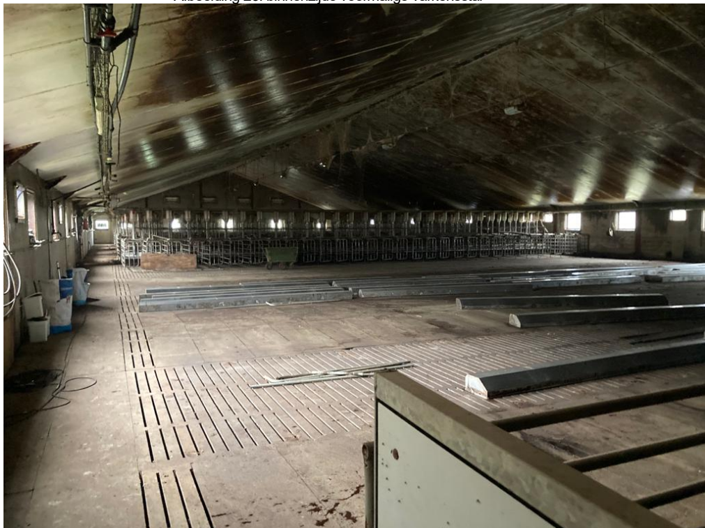
• Afbeelding 26: binnenzijde voormalige varkensstal
