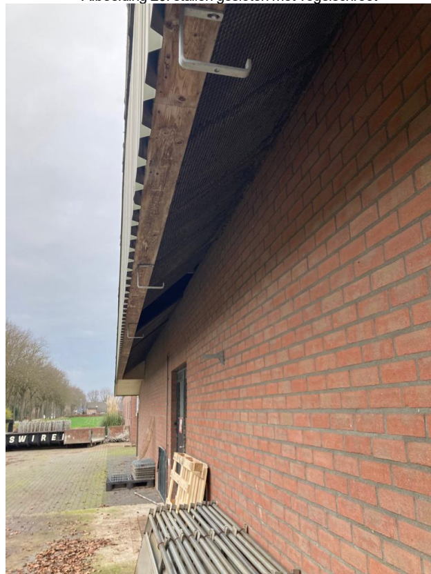
• Afbeelding 20: stallen gesloten met vogelschroot
