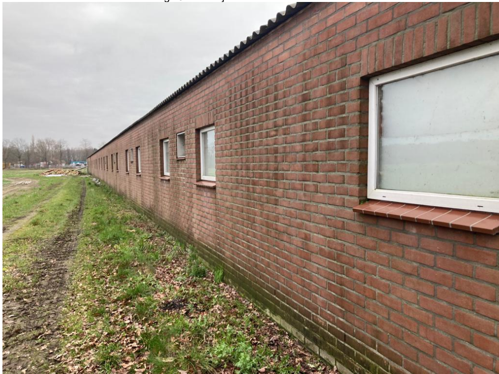
• Afbeelding 23: buitenzijde varkensstallen
