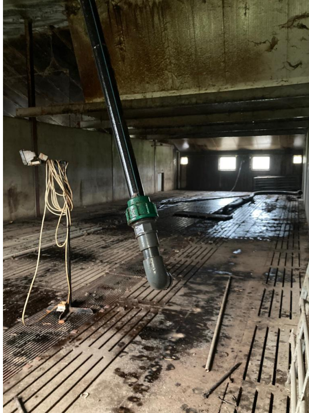
• Afbeelding 25: binnenzijde voormalige varkensstal
