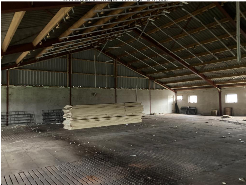
• Afbeelding 24: binnenzijde voormalige varkensstal
