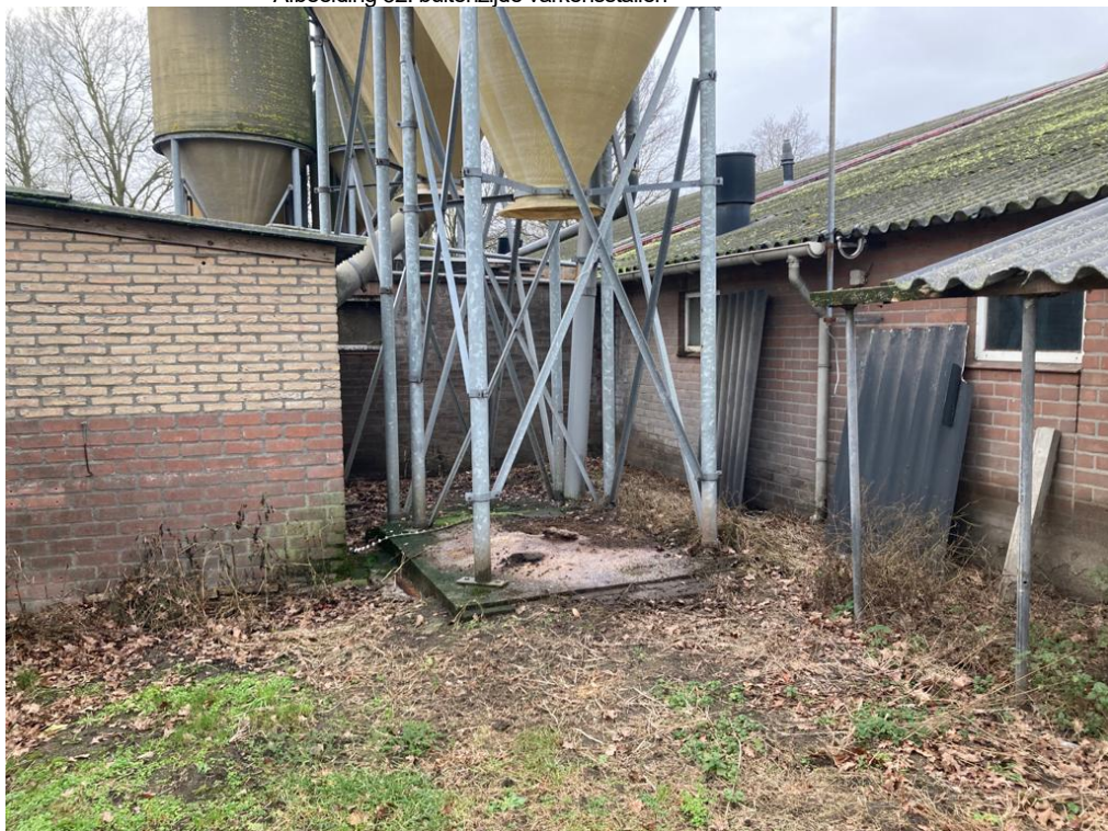
• Afbeelding 32: buitenzijde varkensstallen
