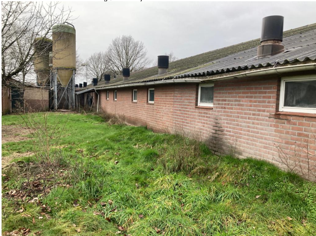
• Afbeelding 31: buitenzijde varkensstallen
