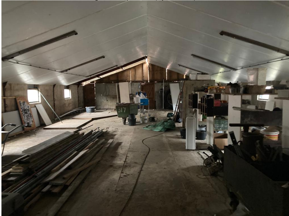
• Afbeelding 5: binnenzijde schuur (blijft behouden)
