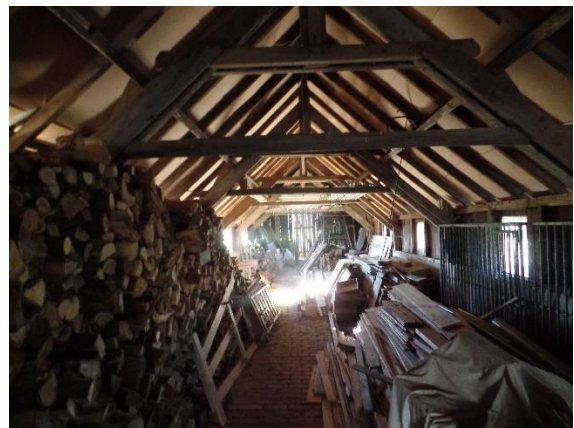
Fig.4 Binnenruimte van de schuur
