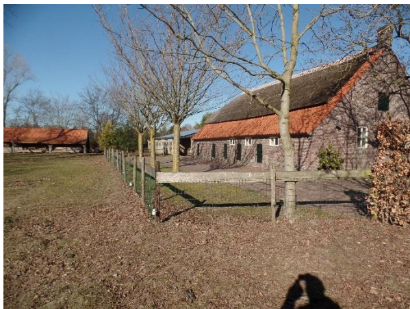
Fig.7 Bijgebouw (wordt niet gesloopt)
