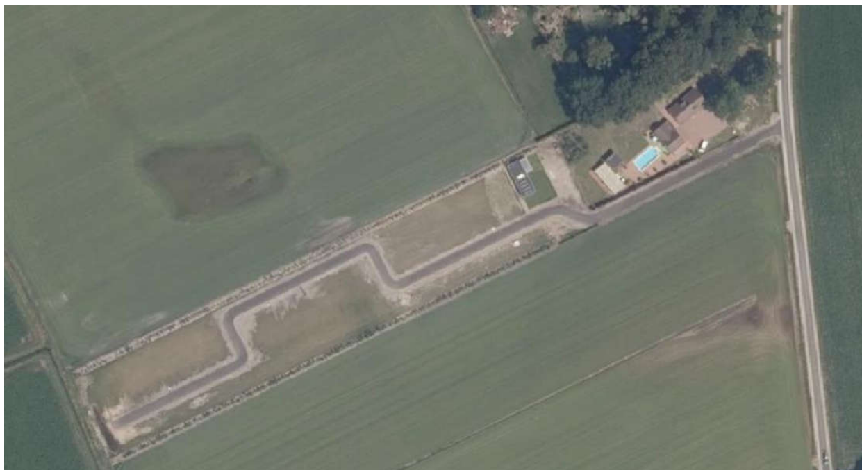
Figuur 8: Luchtfoto recreatiepark aanleg in fase 1
