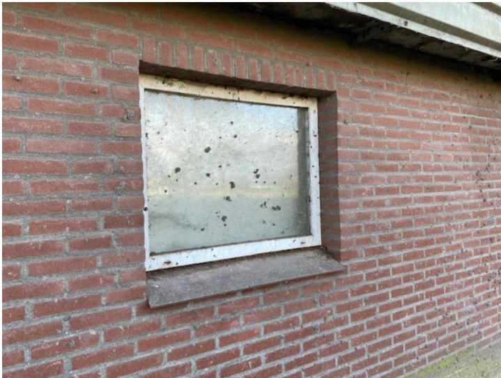
Detail raamkozijn, geen openingen naar de spouw aanwezig
