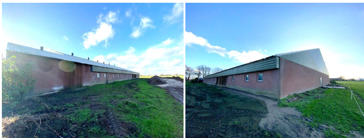
Zijgevel, strak afgewerkt met metselwerk en dakwandbeplating (geen openingen)
