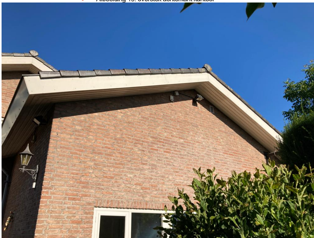
• Afbeelding 19: overstek achterkant kantoor
