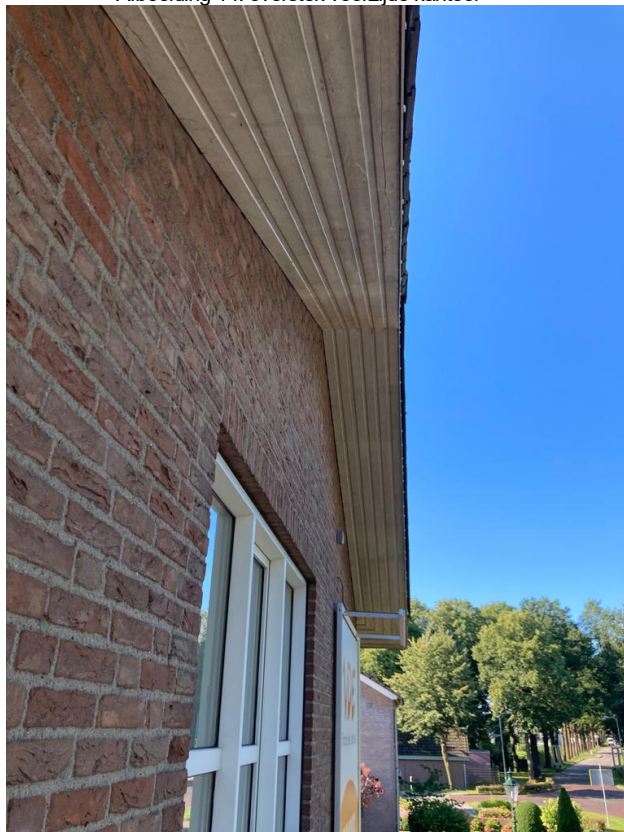
• Afbeelding 14: overstek voorzijde kantoor
