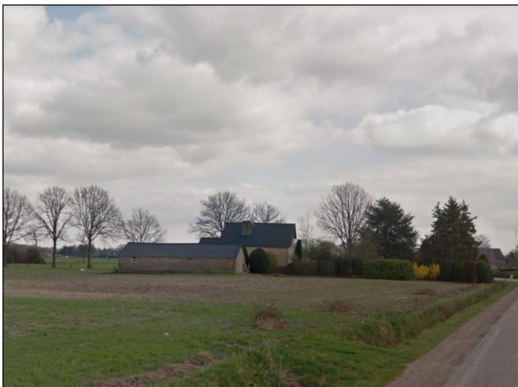
Figuur 7: Plangebied gezien vanaf de Heikantstraat
