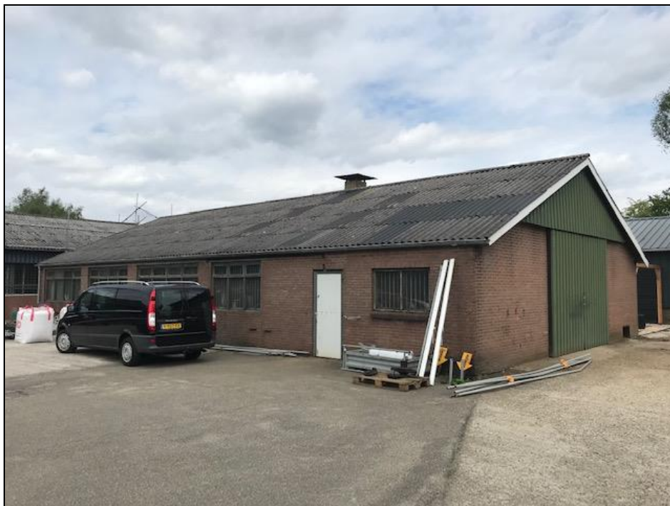
Figuur 8: Te slopen bedrijfshal
