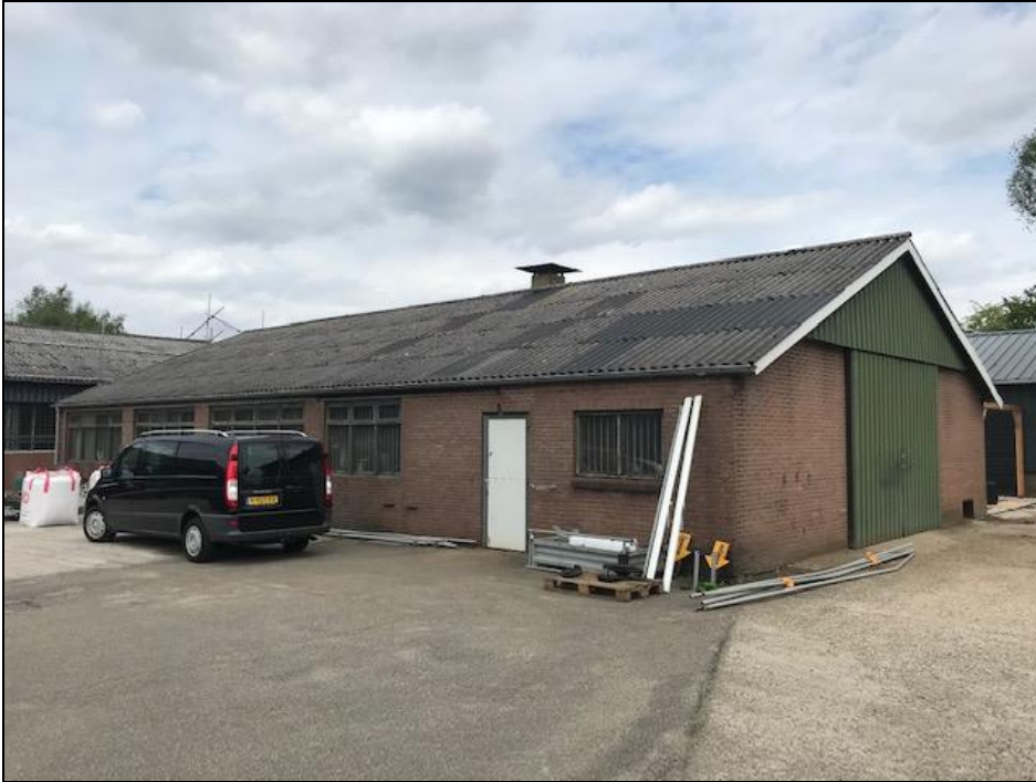
Figuur 8: Te slopen bedrijfshal
