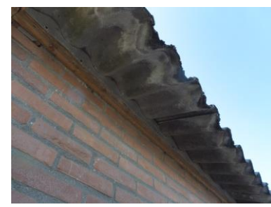
De te slopen loods, een kijkje binnen de loods en zicht op de afgedichte golfplaten met vogelschroot.
