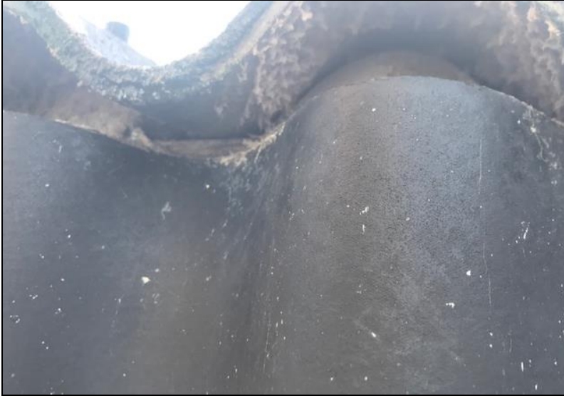
Figuur 21: Het dakbeschoot is ontoegankelijk voor dieren
