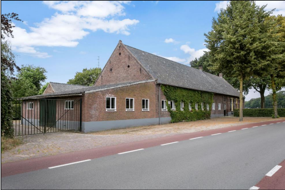
Figuur 6: Langgevelboerderij gezien vanaf Laan ten Boomen
