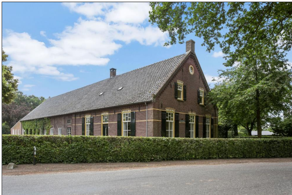
Figuur 5: Langgevelboerderij gezien vanaf de Heesvenstraat
