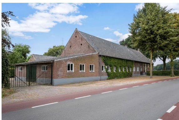
Figuur 3 Eindgevel met aanbouw
