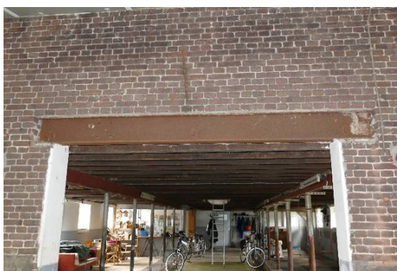
Figuur 16 Interieur van de stal, gezien vanuit de aanbouw. De zolder van de stal wordt gedragen door een reeks ronde ijzeren palen.
