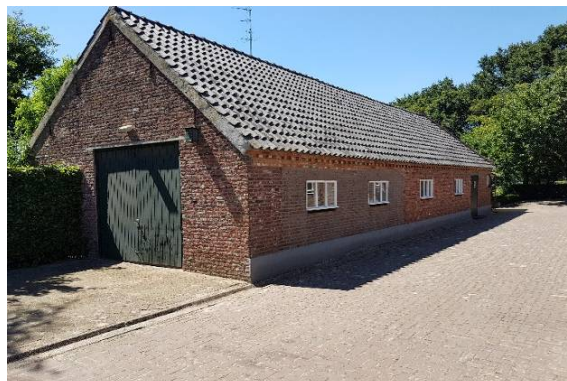
Figuur 24 Schop vanuit het noordoosten met garagedeur voor de tractor. De gevel is opgetrokken uit hergebruikte oude stenen.
