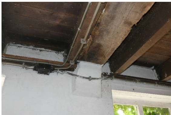
Figuur 18 Eiken ligger in stal die rust op een console in de gevel.
