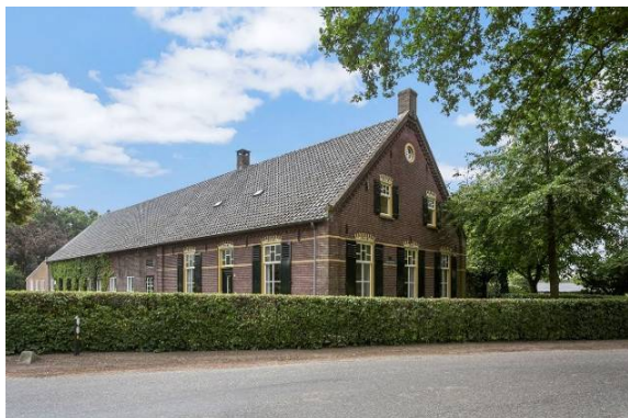
Figuur 1 Voorgevel boerderij
