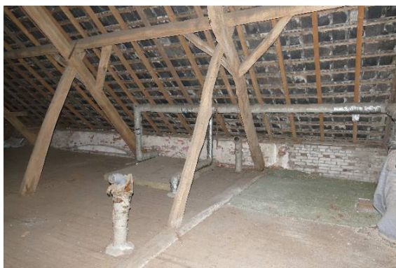
Figuur 22 Links is een stukje van de toog van de mestdeuren van de achtergevel te zien. De spantbenen en voetschoren rusten op de eiken ligger, die gelijk ligt met de huidige vloer.
