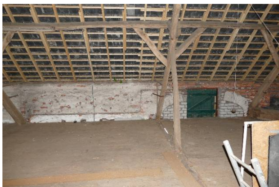
Figuur 21 Het hooiluik rechts ligt in de toog van de voormalige deeldeuren. Deze is, samen met die van de mestdeuren, links, aan de binnenzijde bewaard gebleven.
