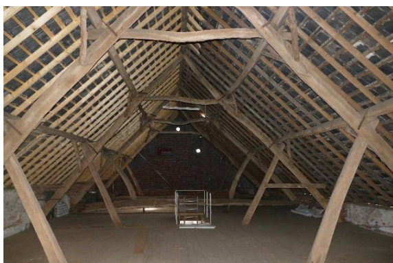
Figuur 19 Kapconstructie boven stal en schuur rustend op vijf gebinten.
