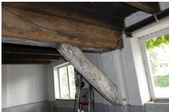
Figuur 17 Eiken ligger in stal die rust op een stijl met schoor tegen de voorgevel. Vroeger werden de stijlen met de muur mee gewit. Men vond een eiken stijl ouderwets en wilde dit camoufleren.
