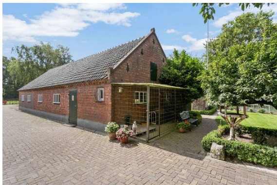
Figuur 23 Het schop heeft een tuitgevel, die een kopie is van de gevel van de boerderij. De gevel aan deze zijde heeft rode Belgische stenen. In het interieur waren voorheen varkenshokken. Thans is het een onverdeelde ruimte met oude machines voor hout- en ijzerbewerking.
