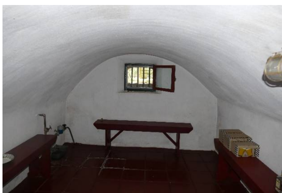
Figuur 14 De kelder met gemetselde toog is een overblijfsel van de afgebrande boerderij.
