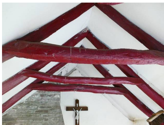
Figuur 28 Het oude sporenkapje van onbewerkt eiken is later in dodekopkleur geverfd.
