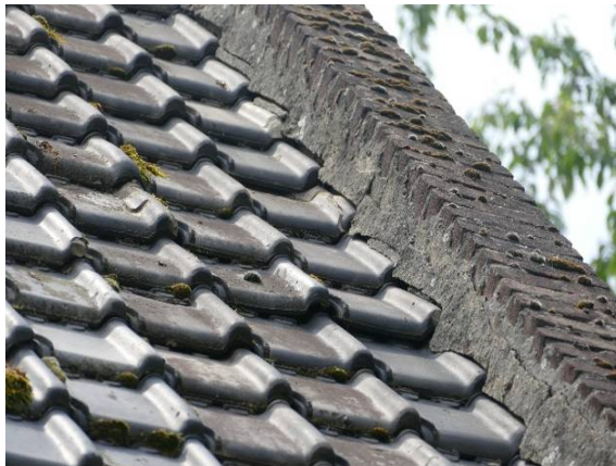
Figuur 7 Het oude type tuile-du-nordpan in dak bij de voorgevel
