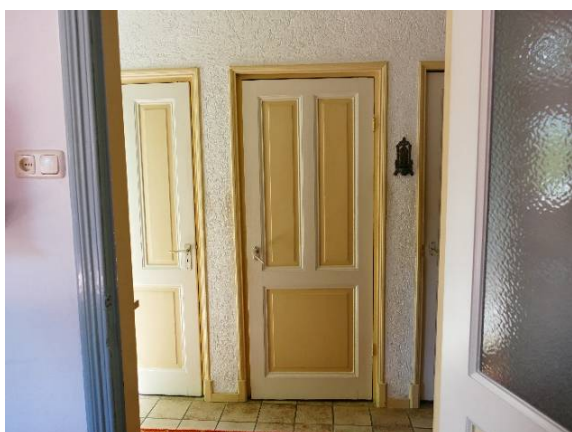
Figuur 13 De deuren naar de opkamer en kelder dateren nog uit de bouwtijd. Zij kwamen toe uit in de keuken, thans komen ze uit in de verlengde gang.
