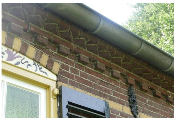
Figuur 6 Detail van woonhuisraam met segmentboog, luik met persienne, ornamenteel metselwerk in dakrand, gevelanker en floraal motief in boogveld.
