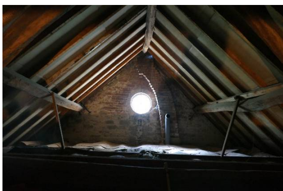
Figuur 15 De kapconstructie boven het woongedeelte heeft geen voetschoren. Deze zijn bij de bouw van de kamers verwijderd en vervangen door twee ijzeren steunen. Rechts naast het ronde raampje loopt het schoorsteenkanaal naar de schoorsteen in de topgevel.
