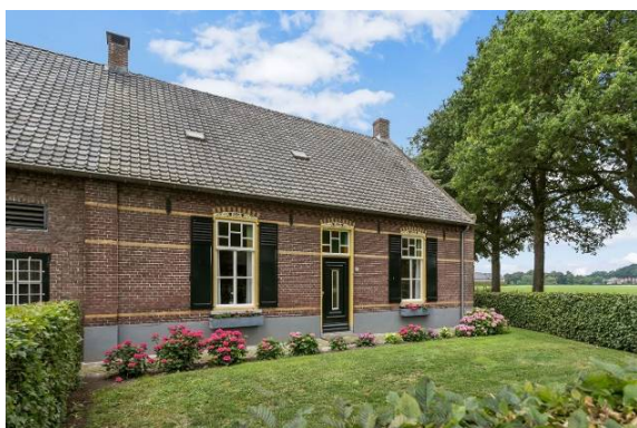
Figuur 5 Het woongedeelte heeft horizontale banden van gele verblendsteen. Het dak loopt aan de voorzijde thans zonder onderbreking door.
