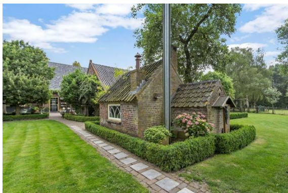
Figuur 25 Het bakhuisje is een zeer charmant gebouwtje, misschien nog daterend uit de tijd van de verbrande boerderij. De oven bevindt zich niet in het midden van de gevel.
