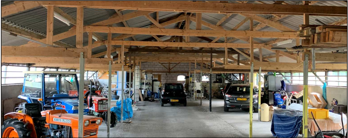
Figuur 37: Beeld van binnenzijde opstallen
