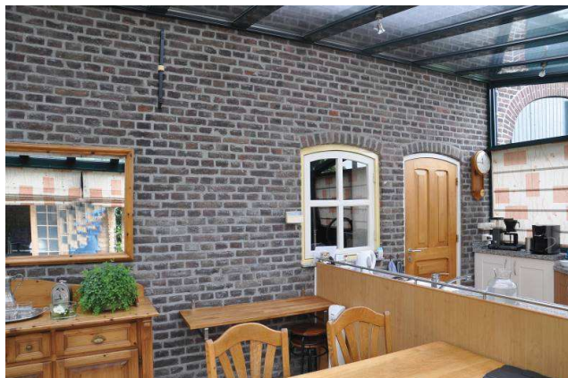
De originele achtergevel is nog steeds aanwezig
