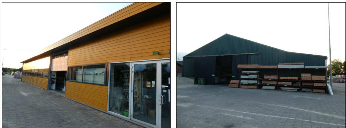
Figuur 8: links: magazijn en kantoor, rechts: houtloods
