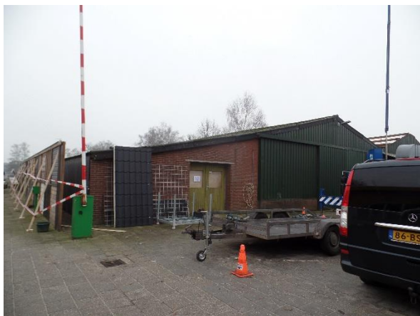
Fig.6 Voorgevel van schuur de te slopen loods
