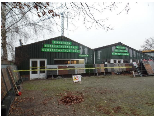
Fig.4 De loods die gesloopt wordt, gezien vanaf de straatkant
