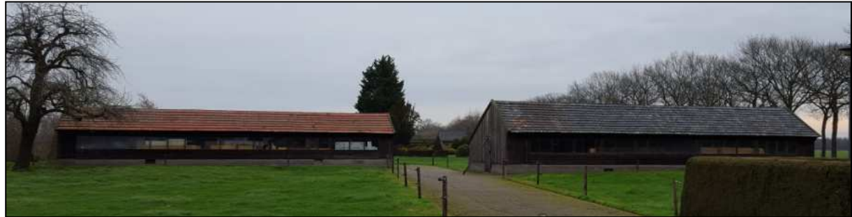
Figuur 27: Te slopen bebouwing binnen het plangebied
