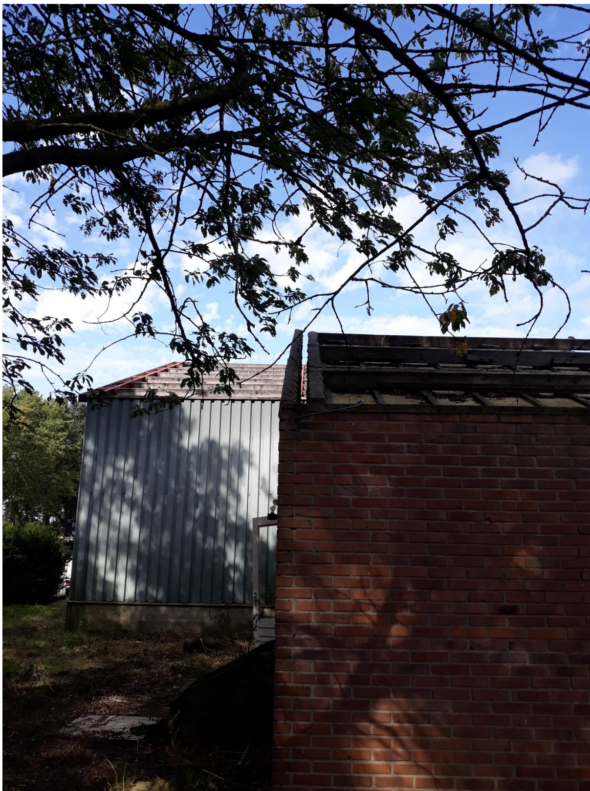
Foto 3. Buitenzijde loods en kantoor met spouw (open bovenzijde)
