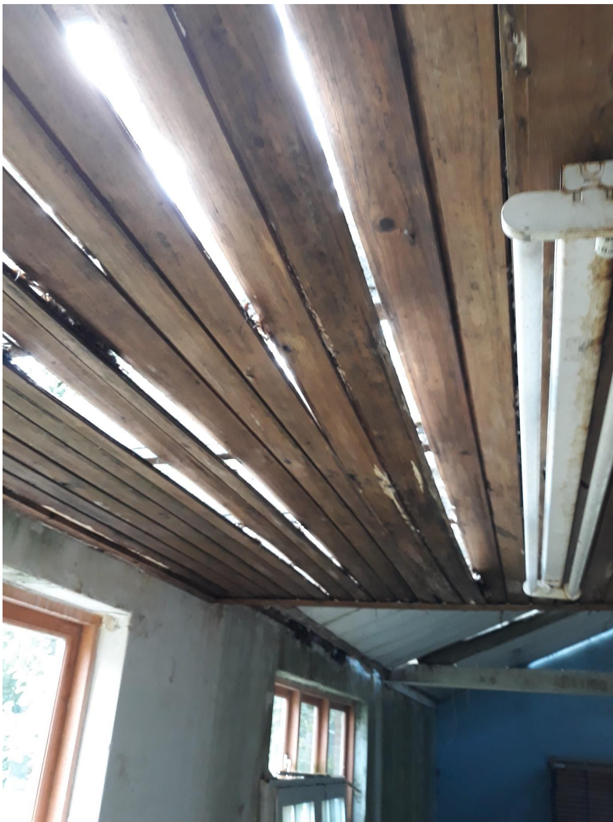
Foto 2. Binnenzijde kantoor met houten plafond
