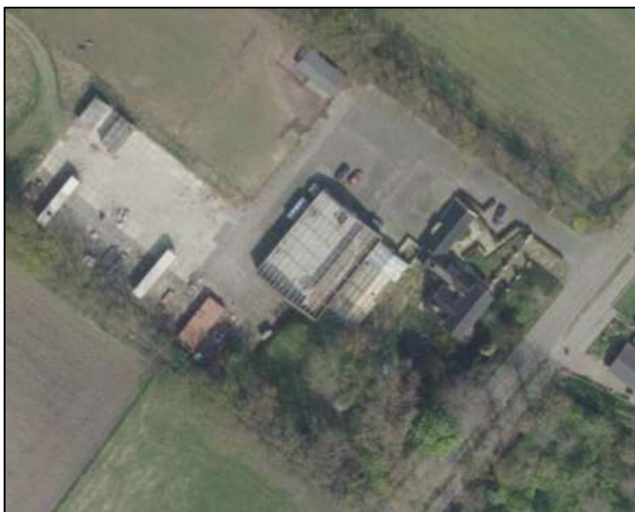
Afbeelding 3: Huidige situatie Kerkendijk 50 te Someren, bedrijfsloods zonder dak als gevolg van stormschade
