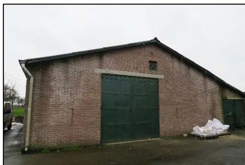
Foto 1. Tot paardenstal om te vormen schuur
