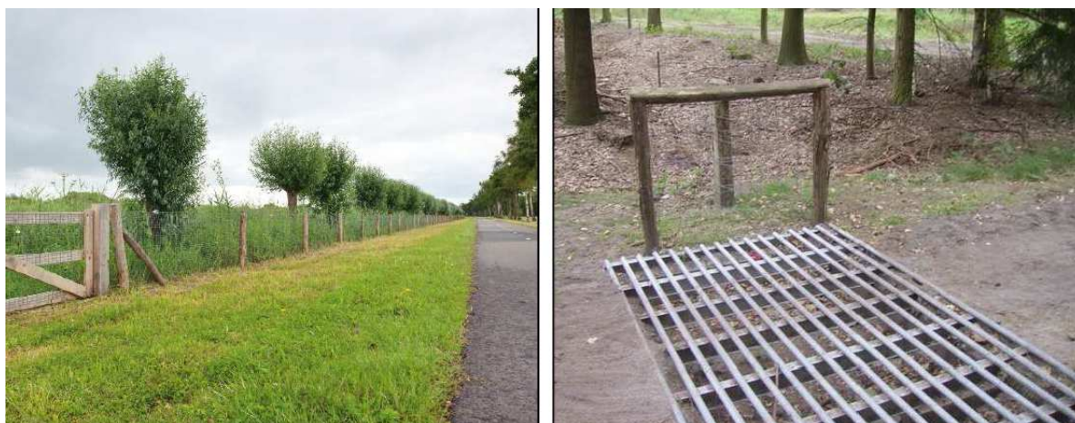
Figuur 4: Voorbeeld van een kleinwildraster (links) en een faunarooster (rechts)
