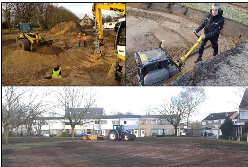
Figuur 6. Compilatie van de methodiek t.b.v. de oplevering van het terrein. Het vlak wordt archeologisch gedocumenteerd, waarna de 'coupegaten' worden verdicht met een verdichtingswiel (linksboven). Na het vlak maken van het 'gele' zand wordt deze aangetrild (rechtsboven). Het terrein is vervolgens aangevuld met het 'zwarte' zand en vlak gereden door een shovel. Door middel van een tractor met Kilverbord is het terrein geheel vlak gemaakt en afgewerkt (onder).
