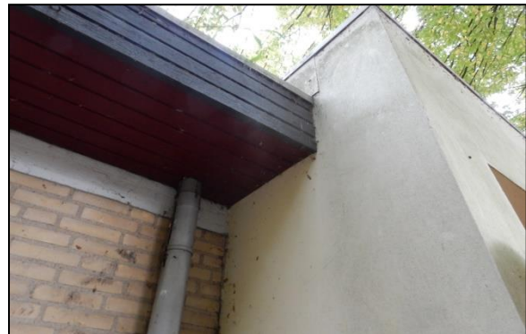
Figuur 10. Detailopname van de overhangende dak betimmering waar aan bij het helwitte vlak een kier is.
