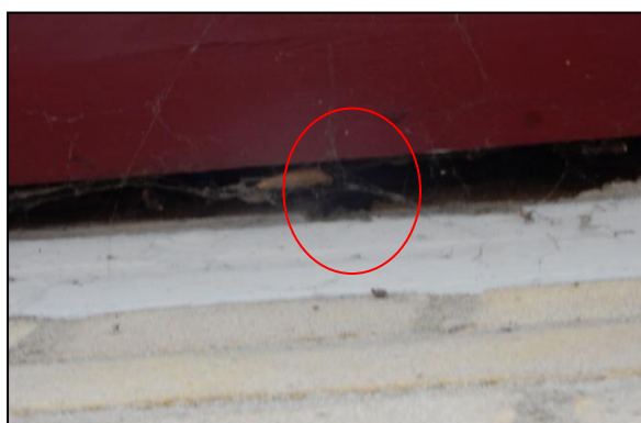
Figuur 11. Detailopname van de kier langs de dakombouw, waar ook meteen een mogelijke stootvoeg te zien is (in rode cirkel).
