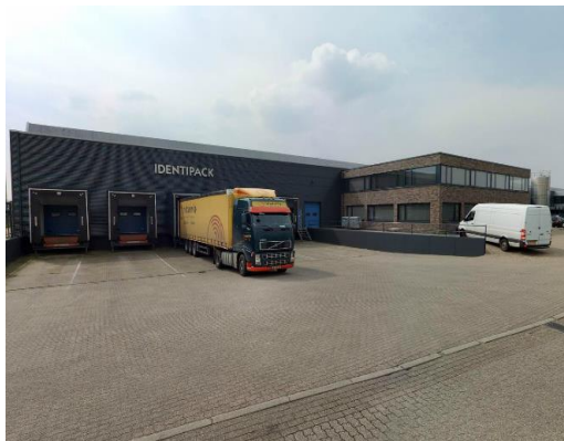
Hernieuwde bedrijfsbebouwing Sluis XI
