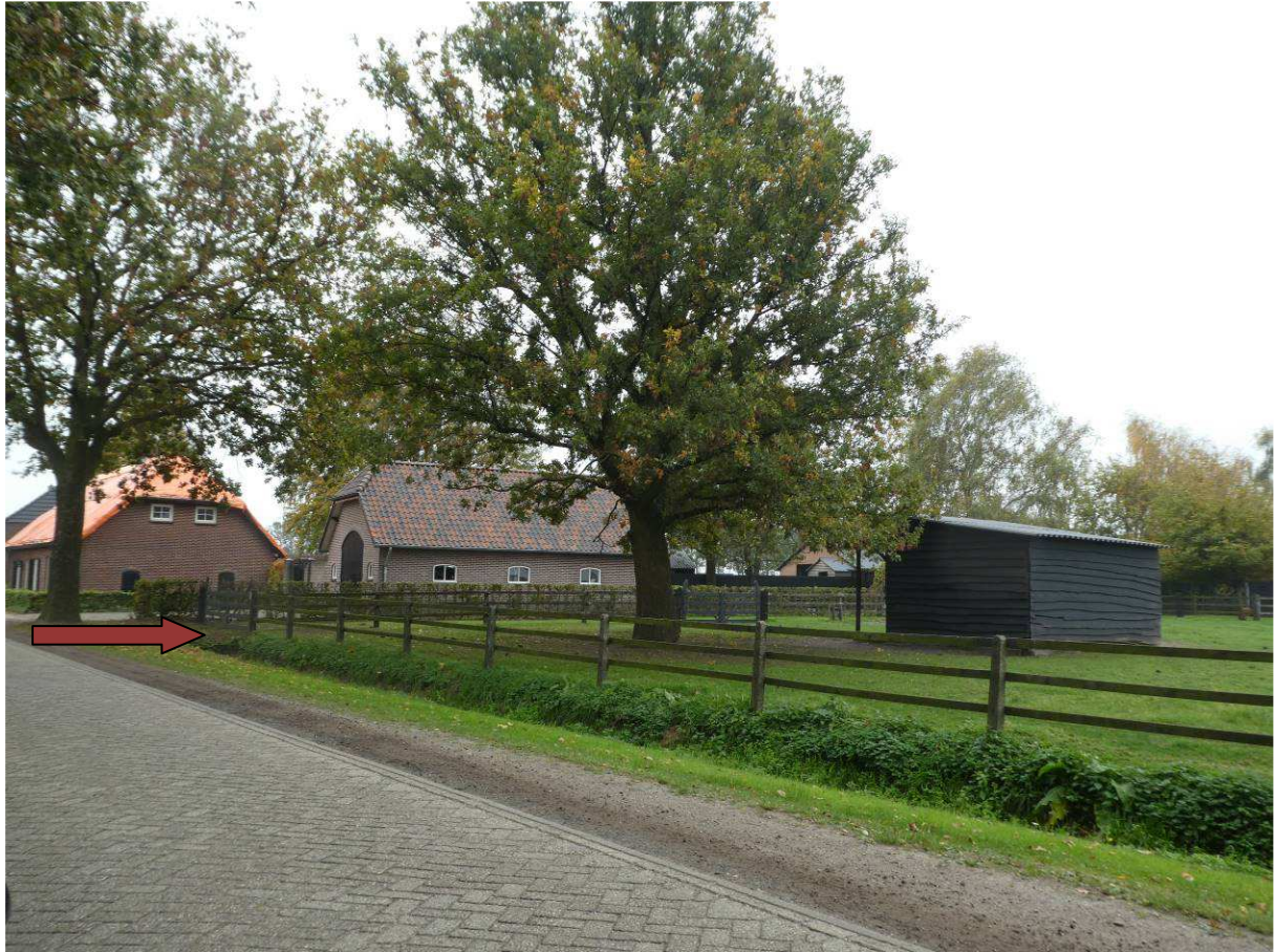
Figuur 13: Beeld ontsluiting van de planlocatie Heikantstraat 26. Met een pijl is de ontsluiting over de bestaande inrit aangegeven
