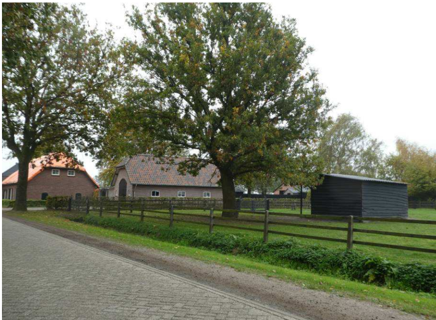
Figuur 1: Foto van de woning aan Heikantstraat 26 (linkerzijde van de foto), het te handhaven bijgebouw (in het midden van de foto) en de beoogde locatie voor nieuwbouw (aan de rechterzijde van de foto)
