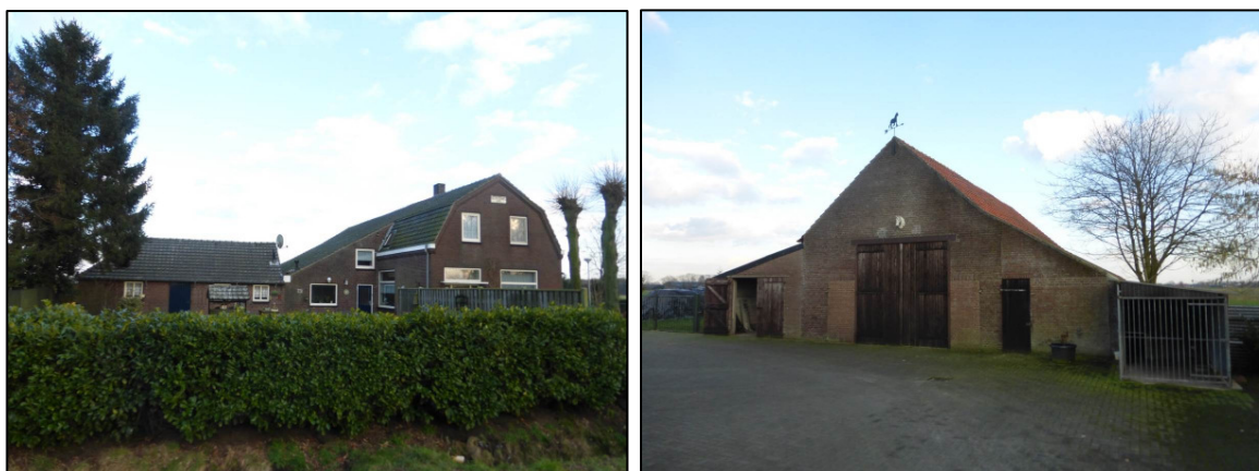
Figuur 5: Te behouden bebouwing
