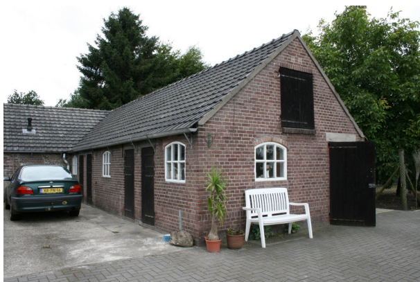
Rechterzijgevel/achtergevel met luik
