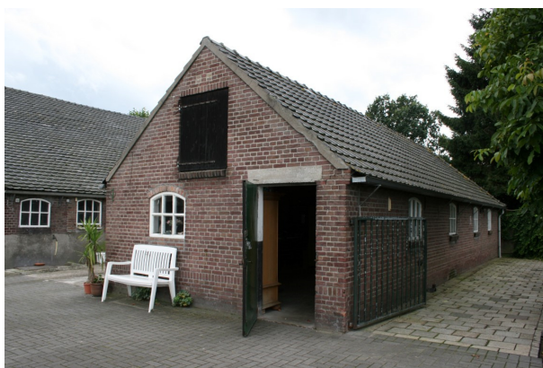
Achtergevel/linkerzijgevel vanaf de achterzijde
