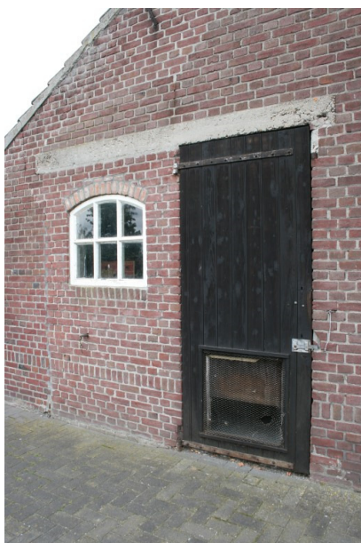
Voormalige dubbele deur
