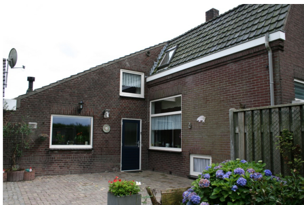
Voorgevel bedrijfsgedeelte links
