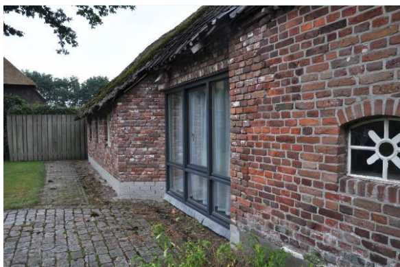
Links in de voorgevel is een tweede staldeur vervangen door een groot venster, dat op het grondniveau beëindigd wordt. In dit deel zijn drie verschillende bouwfasen met dito kleur en voegwerk te ontdekken.
