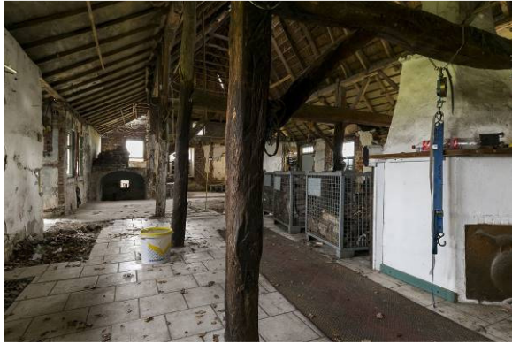
Afbeelding van de schuur/stal, kijkend vanuit het inmiddels voltooide woonhuis. De rij ankerbalkgebinten in de boerderij op een afbeelding van enige tijd geleden, toen het interieur nog bedekt was met keramische tegels.
