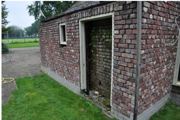
Ook aan deze zijde bestaat de achtergevel uit een dubbele muur, die in de deuropening op een surrealistische manier zichtbaar is.
