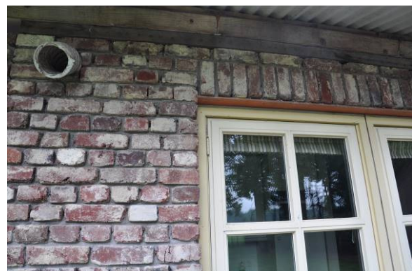
Dit vernieuwde woondeel is op deze plaats reeds geheel afgewerkt. Het metselwerk is gevoegd, maar de afwerking voor de afvoerpijp voor de keuken is nog niet klaar.
