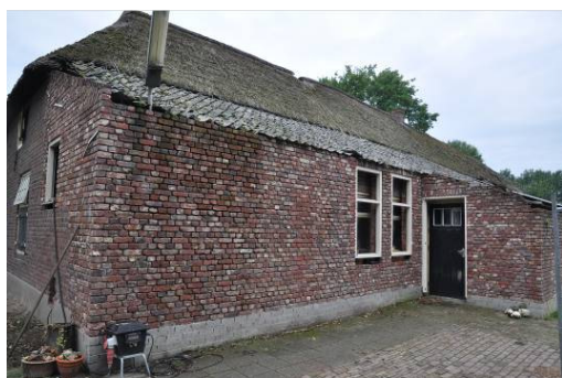
De achtergevel bestaat hier in feite uit een (zichtbare) buitengevel en een binnenwand, die daar 30 cm. tot een meter achter staat.
