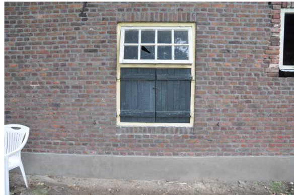
De plint in deze gevel is gecementeerd. Het kloostervenster met klapraam en luiken.
