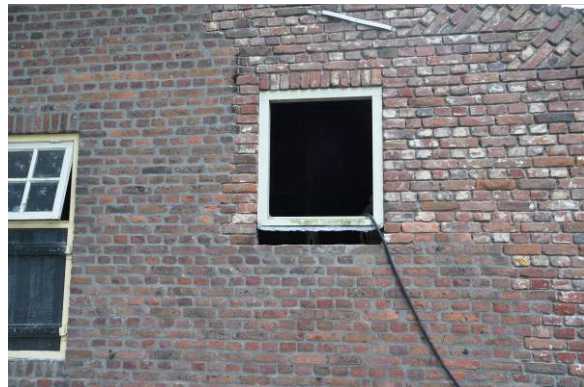
Het opkamerraam dat nog niet gereed is. Alleen de houten kozijnen zijn geplaatst.
