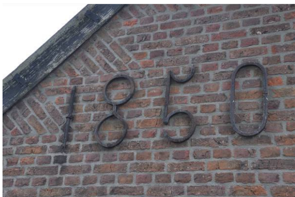
Het anker, dat het cijfer "1" vormt, is op een gebruikelijke manier door de muur in een balk bevestigd. De overige cijfers zijn met schroeven tegen de muur vastgezet.
