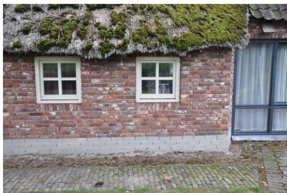
Uiterst links in de gevel een aantal kleine houten vensters, die de vernieuwde huiskamer van licht voorzien. De buitengevel is hier opnieuw gevoegd.
