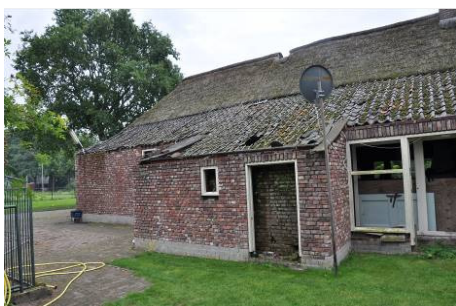
Eenlaagse uitbouw onder lessenaarsdak aan achterzijde.
