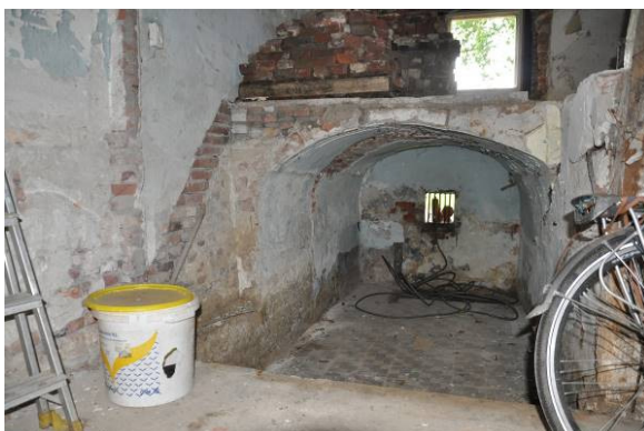
De kelder met in de buitengevel het getraliede kelderraam. De rechterwand (niet op de foto zichtbaar), is opgebouwd met zogenaamde appelbloesembakstenen. Boven de kelder de plaats van de opkamer. Ook in de kelder blauwe verf op de muren.
