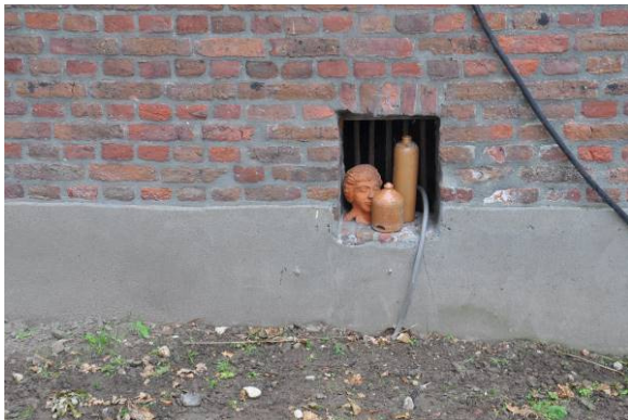
Het kelderlicht met traliewerk. De plint wordt hier doorbroken.
