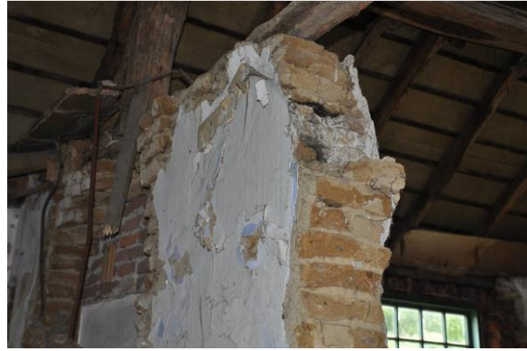
De bovenzijde van het muurtje dat in de schuur staat, en met zongedroogde bakstenen is opgebouwd. Op de wand nog sporen van blauwe verf, die in veel melkveeboerderijen als bescherming tegen vliegen werd aangebracht.
