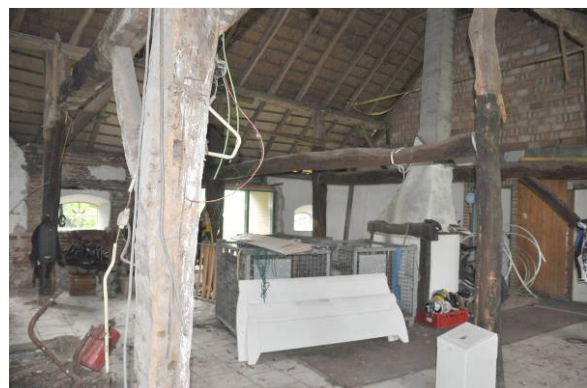
De schoorsteen in deze ruimte staat niet op de plaats, waar deze oorspronkelijk gezeten heeft. Deze is, te oordelen naar de vorm van de schoorsteen op het dak, vermoedelijk tijdens de verbouwing in de jaren '50 op deze plaats gebouwd.
