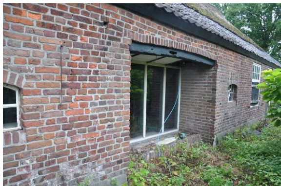
De brede dubbele deeldeur is verwijderd en vervangen door een nisloggia. De originele houten latei is nog steeds aanwezig.
