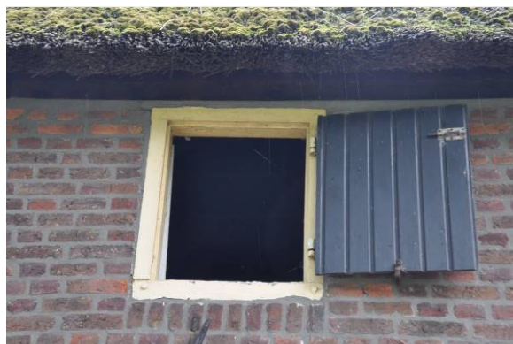
Het zolderraam kan met een houten luik worden afgesloten. Ook hier de metalen luikvastzetters in de vorm van een mannenkopje op buste.
