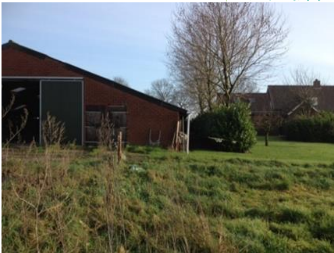
Achterzijde Beliënberkdijk 38-40. Rechts: de 2 e (voormalige) bedrijfswoning op nr.40. Links BBD 38
