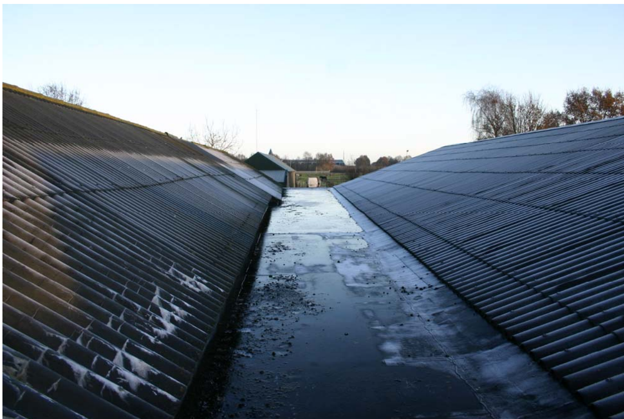
Figuur 4.3. Bovenaanzicht van enkele daken in het plangebied.
